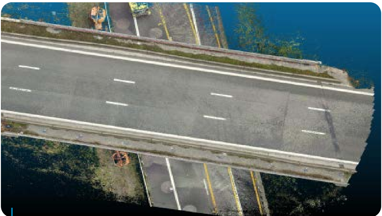
Door middel van fotogrammetrie werd een goed beeld verkregen van het bovenaanzicht van de brug.
