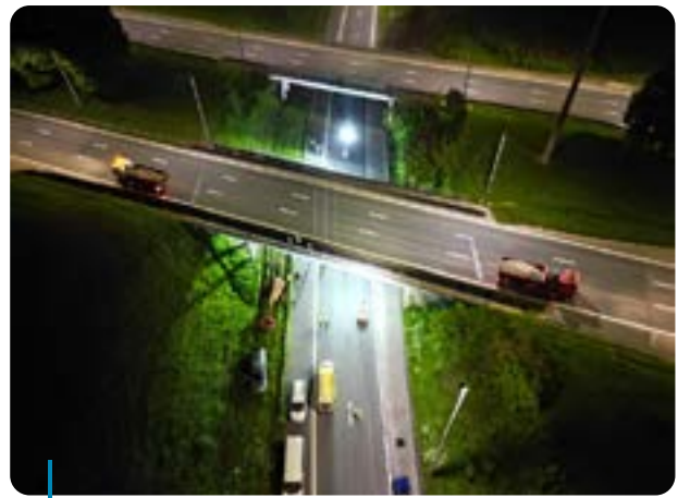
Na een nulmeting werd de brug ook mét een proefbelasting gemeten.
