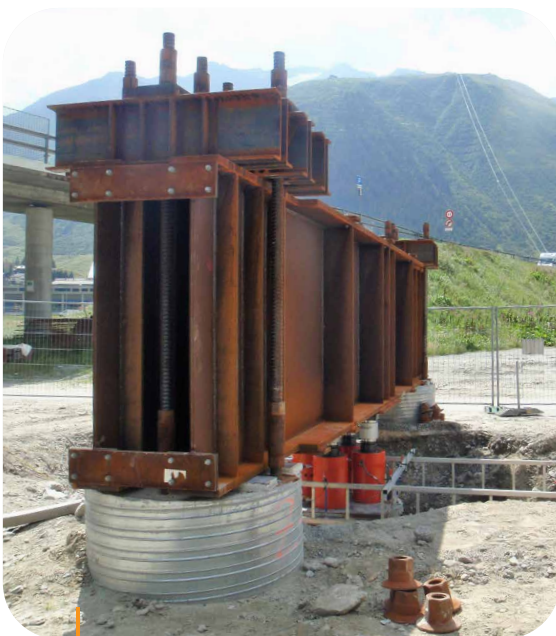
In opdracht van Besix voerde WTCB in het verleden ook een geïnstrumenteerde paalbelastingsproef uit in Zwitserland.
