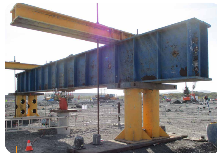
Dankzij geïnstrumenteerde proefbelastingen kan Franki Foundations het draagvermogen van funderingspalen op de site aantonen.
