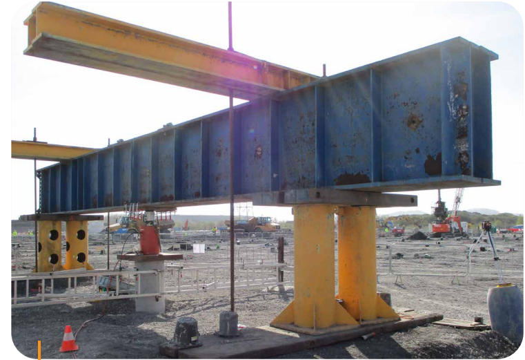
Les essais de chargement instrumentés permettent à Franki Foundations de vérifier la capacité de portance des pieux de fondation sur le site.
