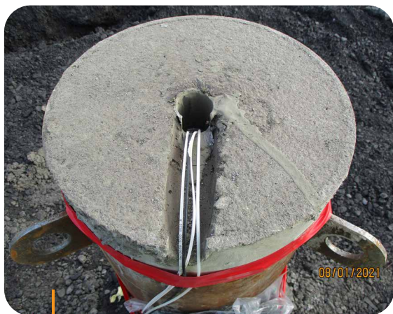
Les capteurs de déformation à fibre optique sont généralement installés dans un tube de réservation en acier après l'installation des pieux, puis guidés vers le côté par une rainure dans la tête du pieu.
