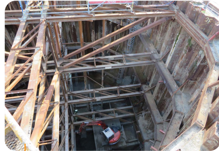
De ondergrond en verschillende uitvoeringstechnieken werden uitgebreid getest door middel van een 24 meter diepe proefput.
