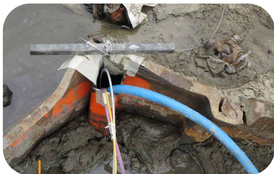
Un tube en acier a été soudé sur les palplanches, puis des jauges de déformation ont été placées dans ce tube après l'installation des palplanches.
