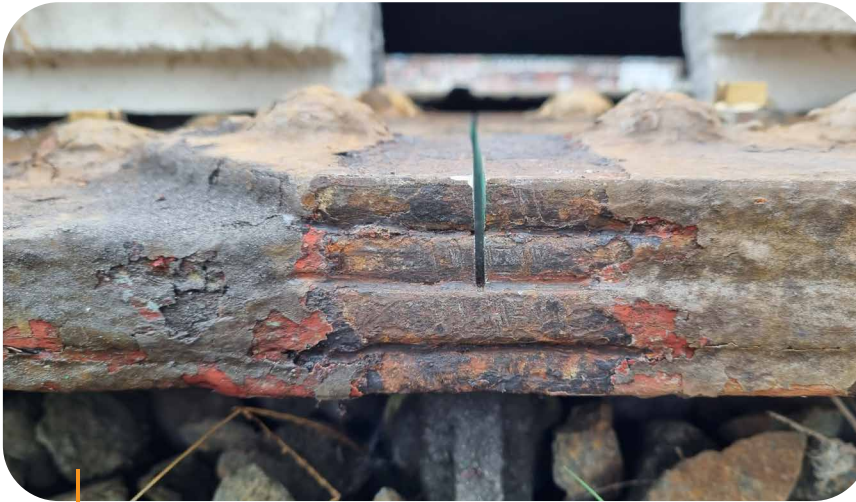
Bien que d'une profondeur limitée, les fissures du projet à Renaix ont eu une influence manifeste sur les modes propres de déformations optiques.
