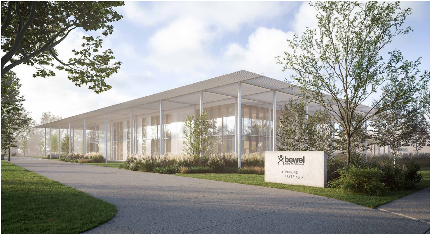
La présence d'un grand auvent permet de se passer de stores automatiques, ce qui se révélera très intéressant en matière de maintenance.
