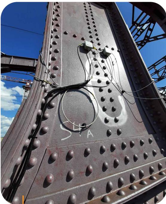
TUC Rail et Infrabel espèrent pouvoir allonger considérablement la durée de vie des infrastructures grâce au contrôle de santé intégré.
