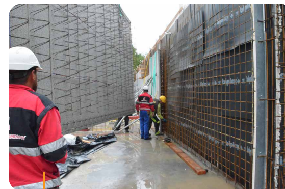
L'élément en béton préfabriqué est placé contre la paroi de soutènement.
