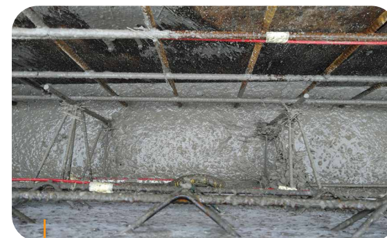
Pour le monitoring, des câbles à fibre optique mesurant la déformation et la température du béton de remplissage ont été fixés sur les barres d'armatures à différentes hauteurs.
