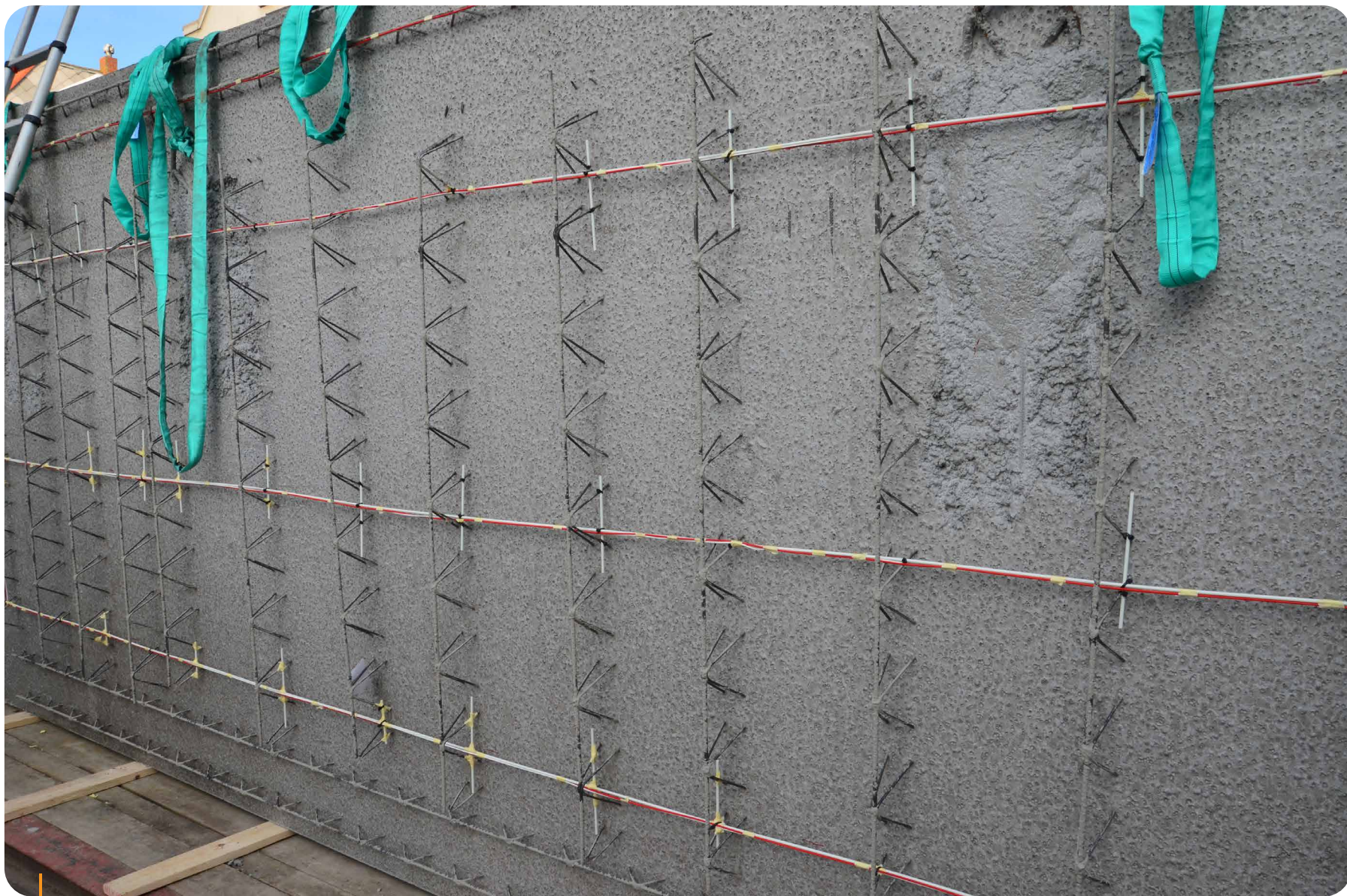
Détail de la fixation des câbles de mesure par fibre optique sur l'armature de l'élément en béton préfabriqué.
