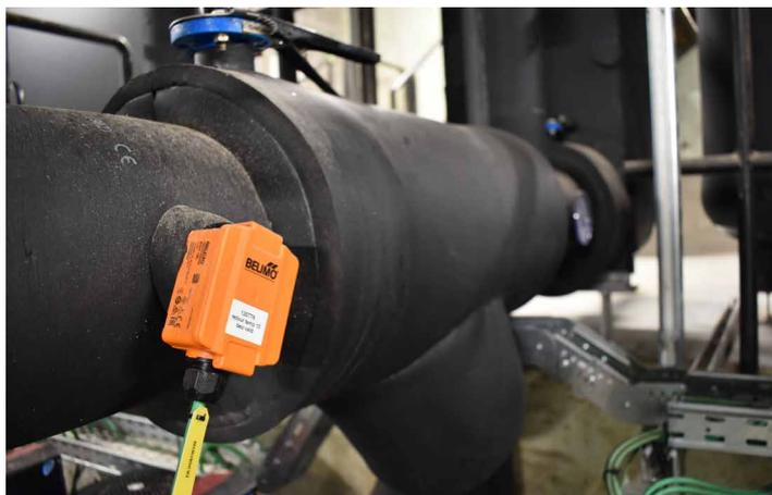
Des capteurs permettent de mesurer à peu près tout. Ici, il s'agit du suivi de la température de retour du champ BTES (stockage géothermique par puits de forage).
