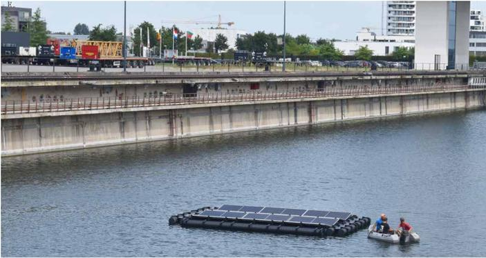
Des panneaux photovoltaïques flottants sont installés dans le dock afin d'étayer la théorie selon laquelle l'effet refroidissant de l'eau peut augmenter la productivité des panneaux PV.
