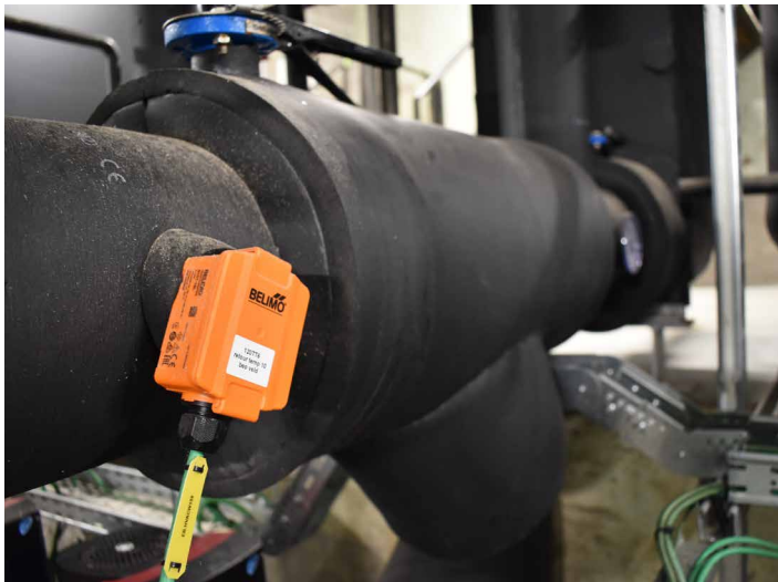
Alle installaties worden in detail bemeten. In dit geval gaat het om de monitoring van de retourtemperatuur van het BEO-veld.
