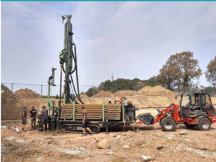
Les sondes géothermiques du champ BTES sont introduites dans le sol à l'aide d'une foreuse.
