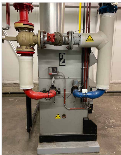
Le module peut être installé en une demi-heure sur le côté extérieur de chaque type et marque d'installation HVAC avec chaudière, pompe à chaleur ou unité de cogénération.
