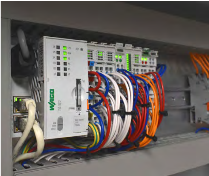
De multi-site managementtool maakt gebruik van een WAGO PLC die toelaat om in functie van de noden verschillende types I/O's aan te sluiten.
