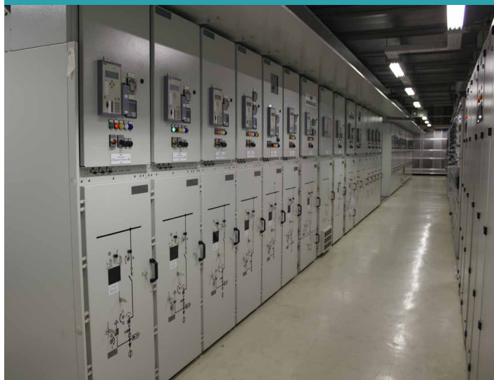
De apparatuur die de hoogspanning in middenspanning omzet, blijkt bijzonder gevoelig te zijn voor temperatuur en vochtigheid.
